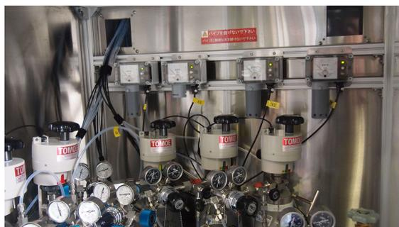
シリンダーキャビネット内にガスセンサーを取り付け、常時監視することで安全性大幅にアップ
